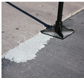
Área de reparación de apisonamiento
