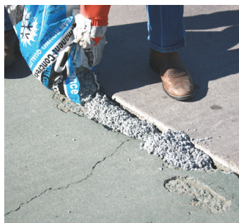
Área de reparación de llenado
