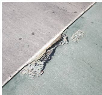
Área de reparación limpiada
