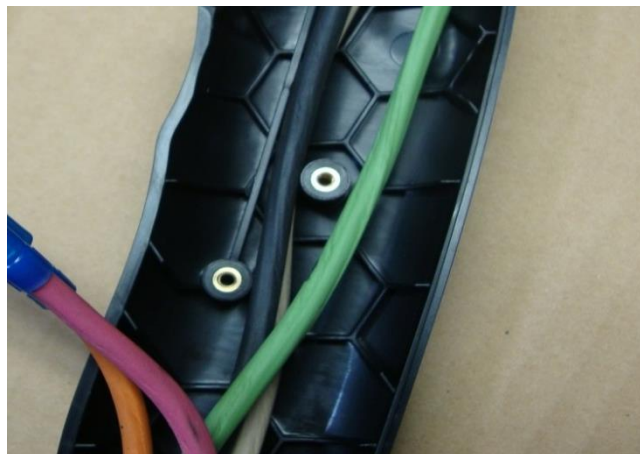
Fig. 6-16 Ubicación de los Cables
