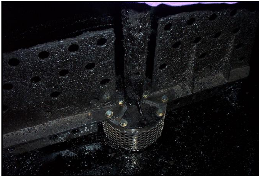
Fig. 6-10 Montaje del Eje del Agitador y de las Paletas
