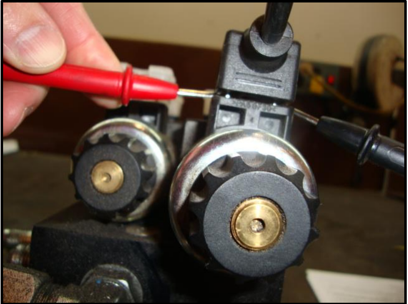
Fig. 8-6 Checking Din Plug Voltage
