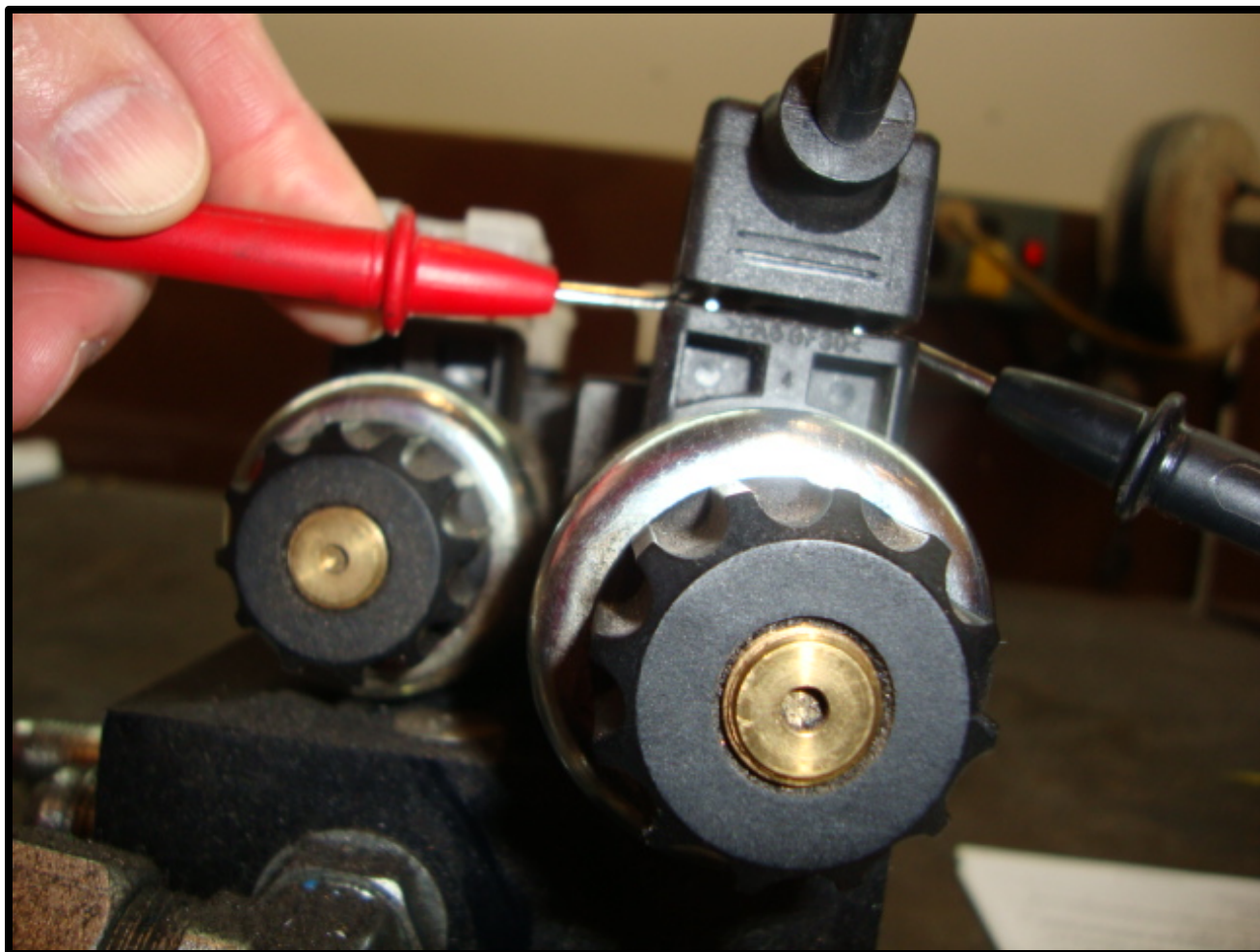
Fig. 8.4 Checking Din Plug Voltage
