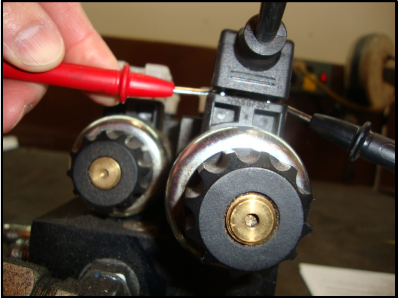
Fig. 8-6 Checking Din Plug Voltage
