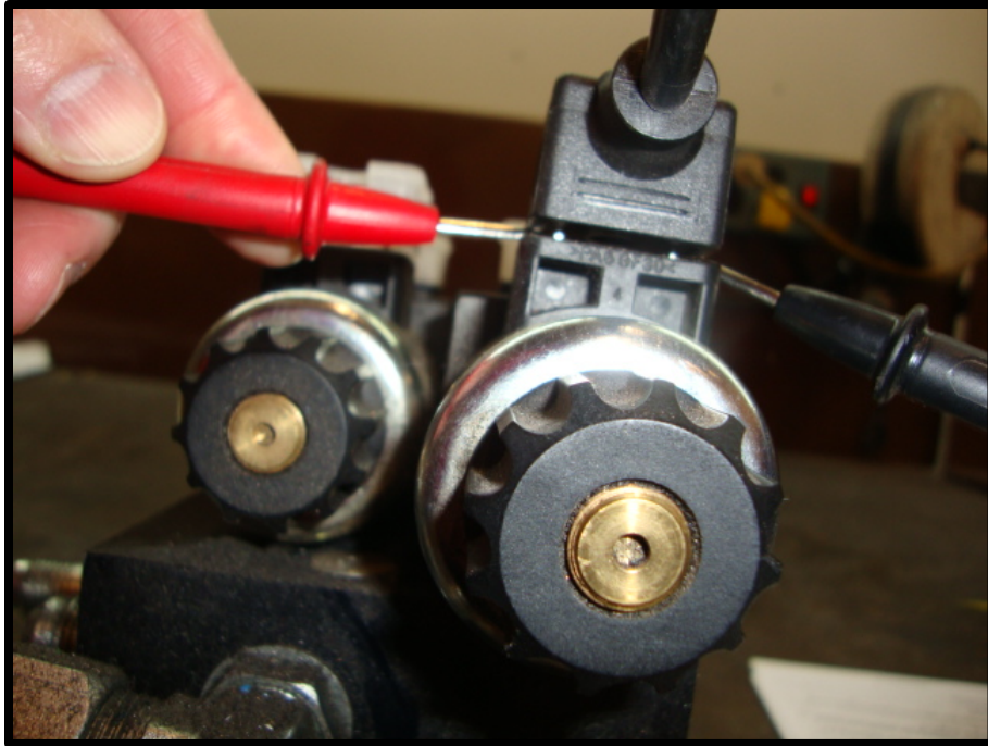
Fig. 8.4 Checking Din Plug Voltage
